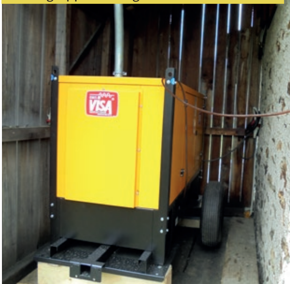
Nuovo gruppo elettrogeno - Fossernica di fuori
