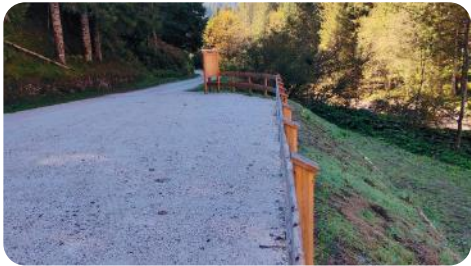
Pont de Stel
