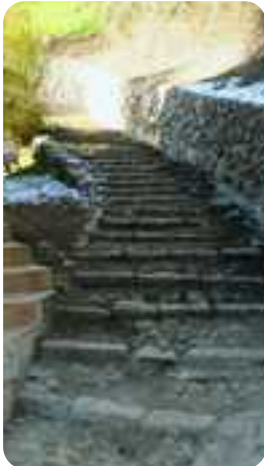
Ripristino muri Val dei Faori
