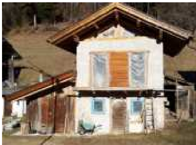
Fotografia anno 2002 (pre ristrutturazione con ampliamento)
