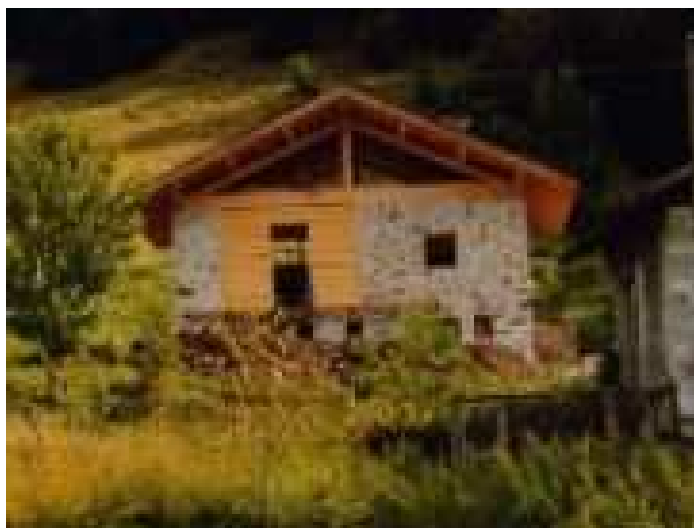
Fotografia anno 2002 (con ristrutturazione in corso)
