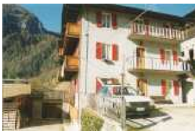
Fotografie anno 2002 (pre ristrutturazione)
