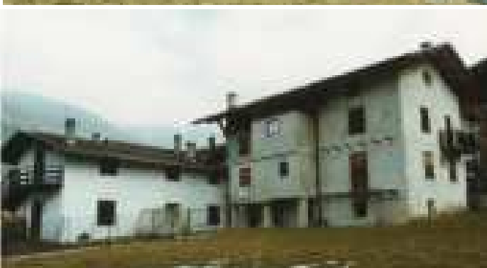
Fotografie anno 2002 (pre ristrutturazione)
