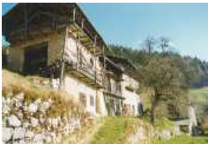
Fotografia anno 2002 (porzione centrale ancora con copertura in essere)
