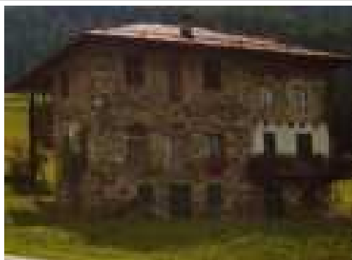
Fotografia anno 2002 (pre risanamento)
