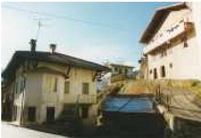
Fotografia anno 2002 (pre intervento)
