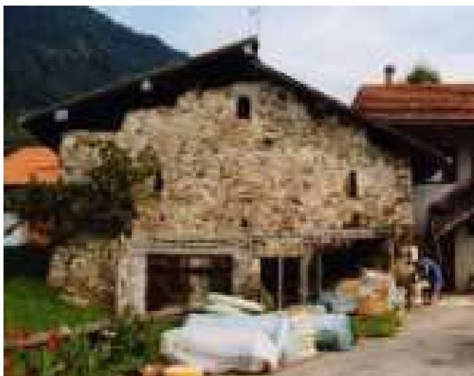
Fotografia anno 2002 (pre intervento di rifacimento copertura)
