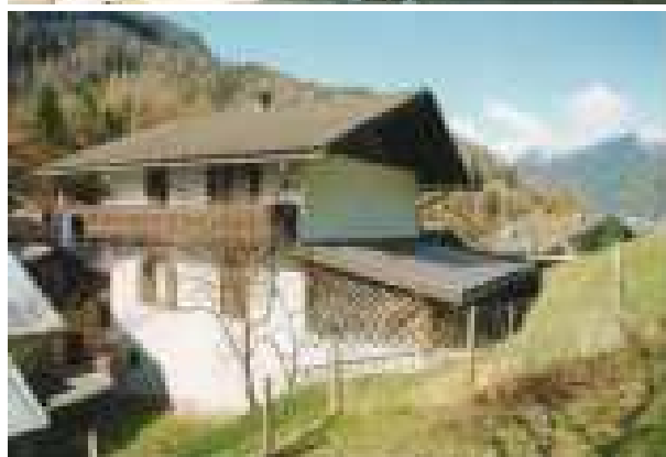
Fotografie anno 2002 (pre ristrutturazione)
