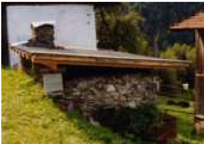
Fotografia anno 2002 (pre ristrutturazione)
