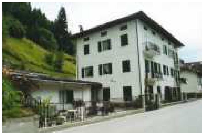
Fotografia anno 2002 (ante demolizione e ricostruzione)
