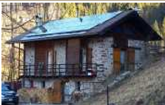
Fotografia anno 2002 (ante ristrutturazione)
