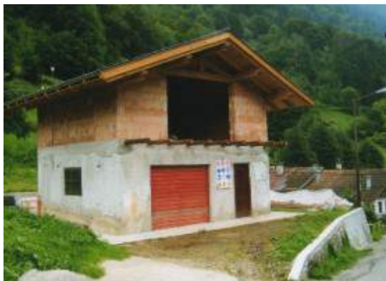
Fotografia anno 2002 (ristrutturazione in corso)
