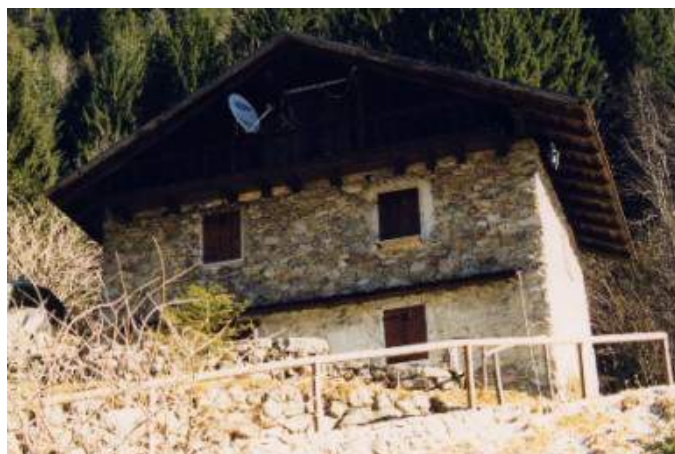
Fotografia anno 2002 (pre intervento di risanamento)
