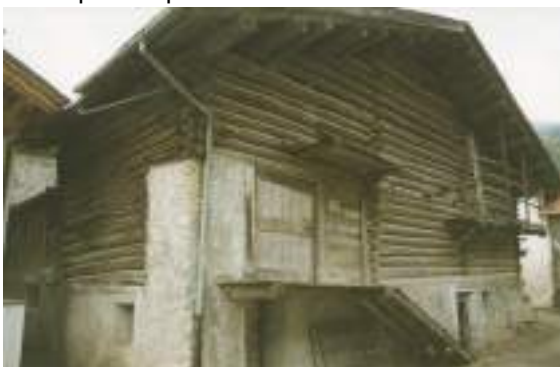
Foto 2002: parte di edificio in blockbau sito a monte, attualmente rimangono solo le murature
