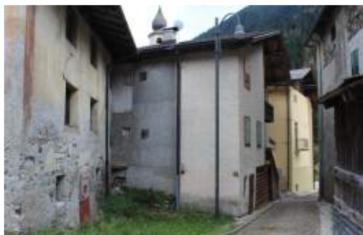
Porzione fronte a monte
