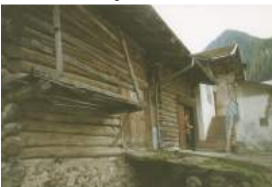
Fronte laterale in blockbau di cui rimane solo la parte dx
