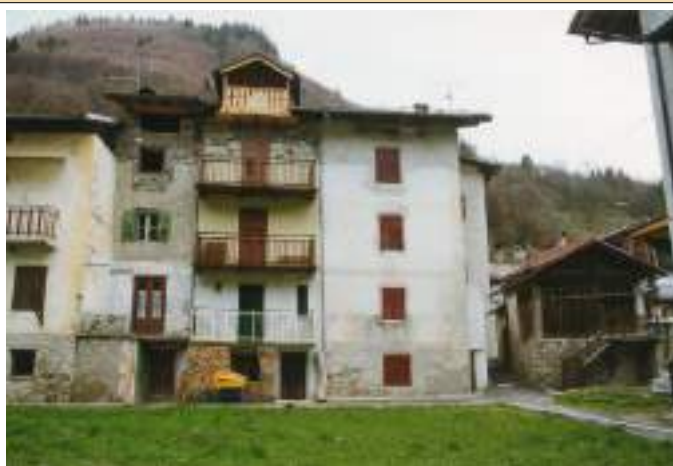
Fotografia anno 2002 (pre ristrutturazione)
