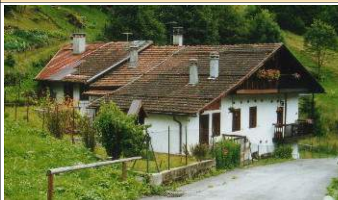
Fotografia anno 2002 (pre risanamento)
