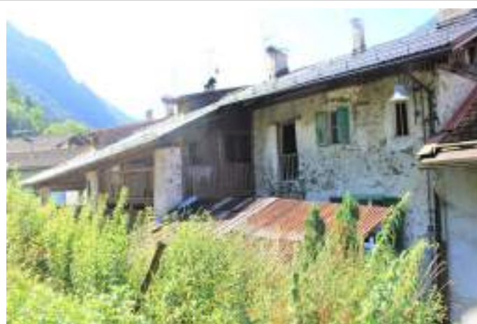
Vista a monte
