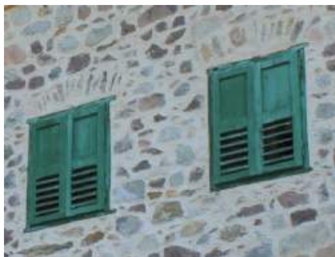
Particolare muratura e architravi con sasso a vista
