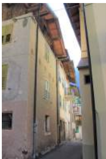
Fronte a valle
