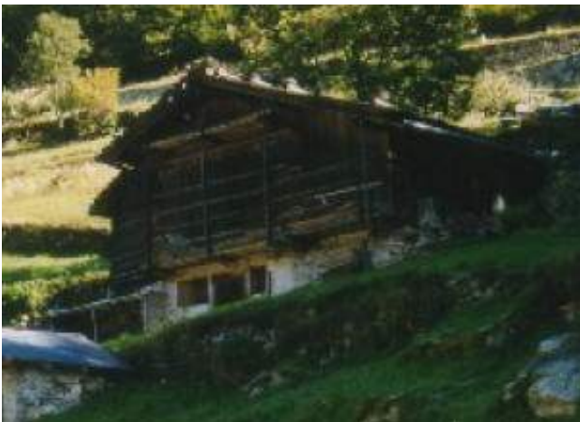
Fotografia anno 2002 (pre risanamento)
