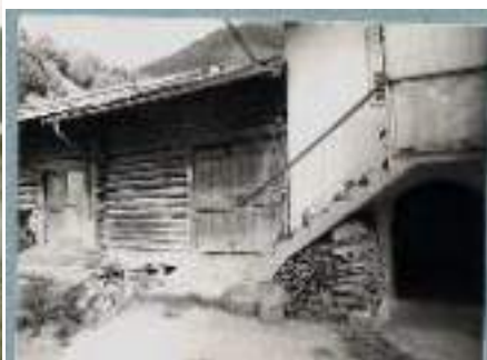
Fronte laterale in blockbau di cui rimane solo la parte dx
