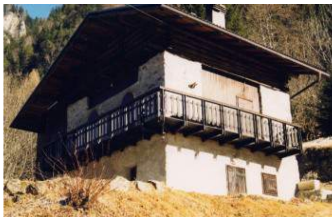
Fotografia anno 2002 (pre intervento di risanamento)
