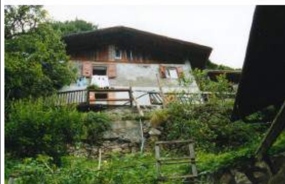
Fotografie scheda anno 2002 (pre ristrutturazione)
