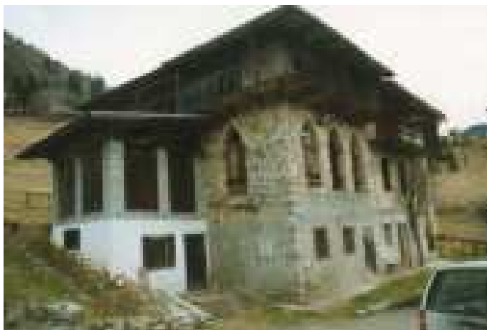
Fotografia anno 2002 (pre risanamento)
