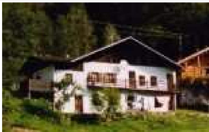
Fotografia anno 2002 (pre ristrutturazione)
