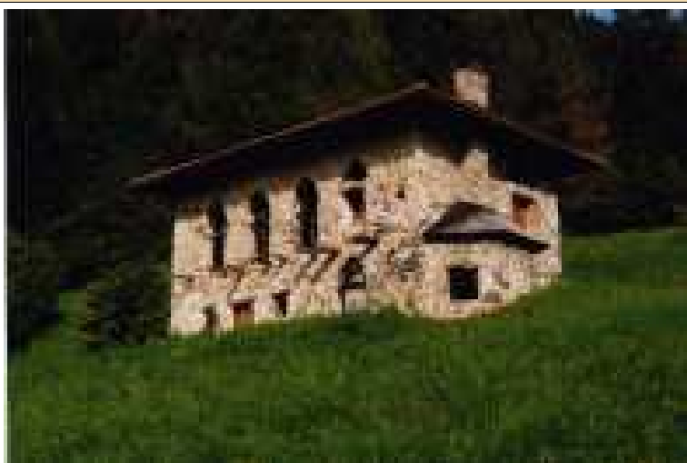
Fotografia anno 2002 (pre risanamento)
