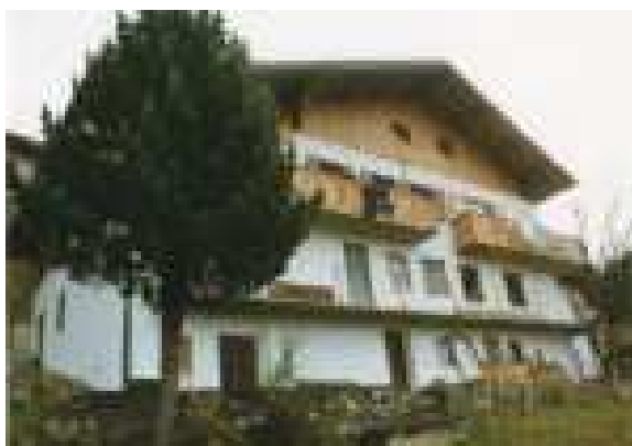
Fotografia anno 2002 (con ristrutturazione in corso)
