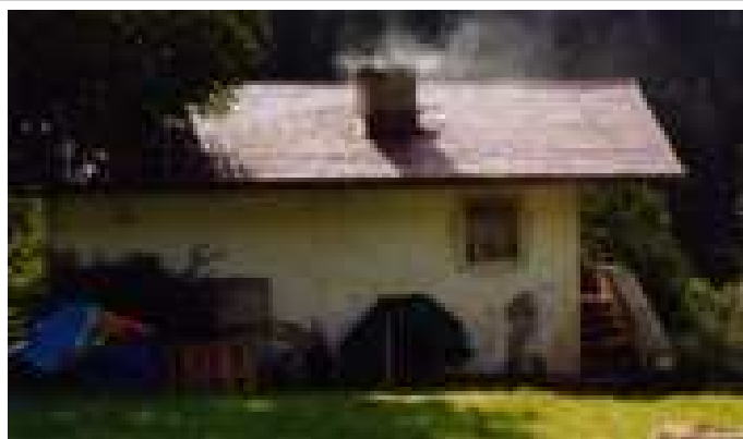
Fotografia anno 2002 (pre rifacimento copertura)
