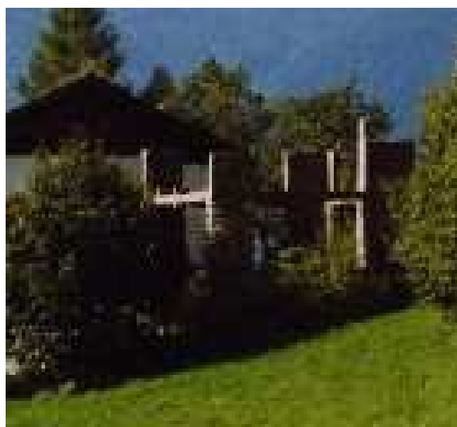
Fotografie anno 2002 (edificio in ristrutturazione)
