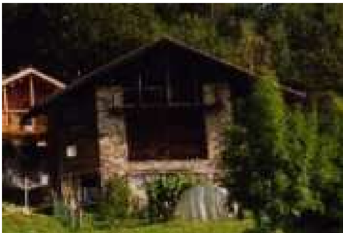
Fotografia anno 2002 (pre intervento di risanamento)
