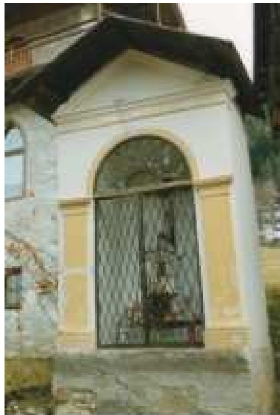
Fotografia anno 2002 – pre intervento
